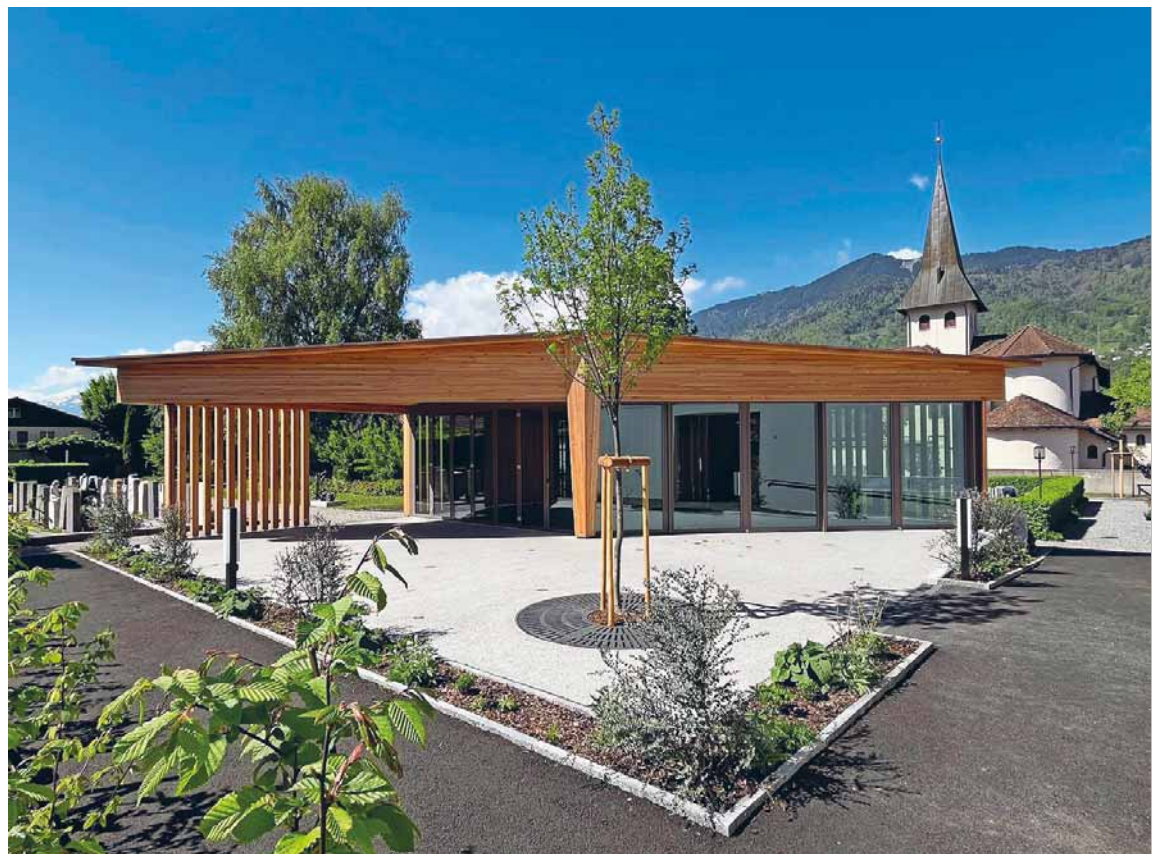
Der neue Trauerraum fügt sich behutsam in die Anlage von St. Fidelis ein und bleibt dennoch klar erkennbar.
